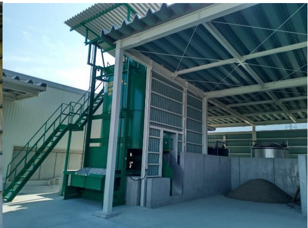
図4:密閉縦型発酵装置
