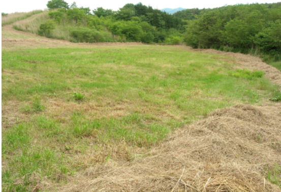
ススキ、ササを撤去した状況(6月15日)
